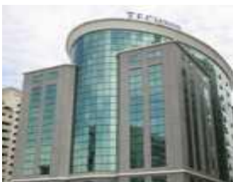
Wisma TechnipFMC (b)
